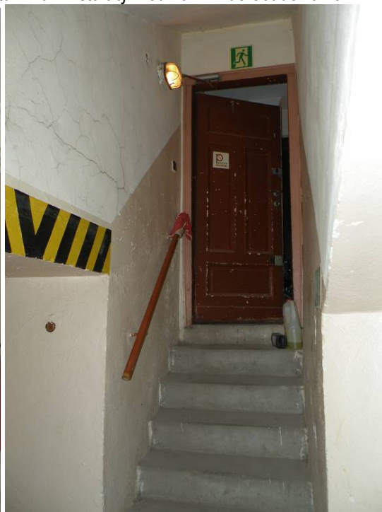
klatka schodowa – schody i drzwi do piwnicy
