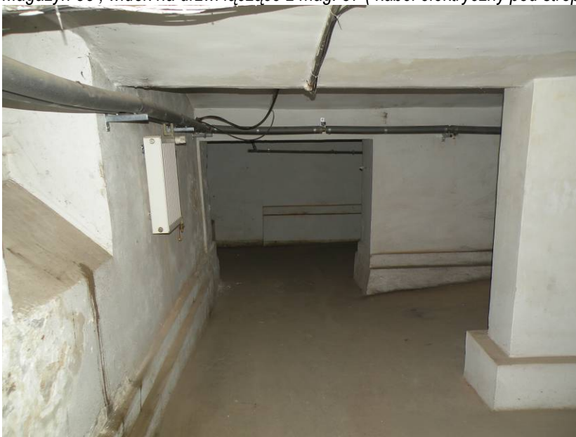
Magazyn 38 , widok na przejście do mag. 39 ( z lewej kabel elektryczny pod stropem)
