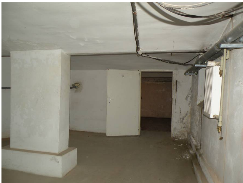
Magazyn 38 , widok na drzwi łączące z mag. 37 ( kabel elektryczny pod stropem)
