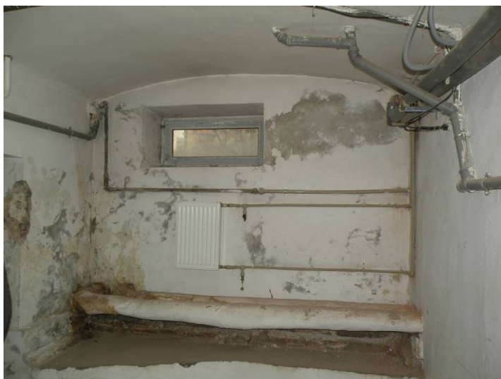
Magazyn 39 – widok okna w ścianie zewn., podestu i rur instalacji wod-kan. – do obudowania
